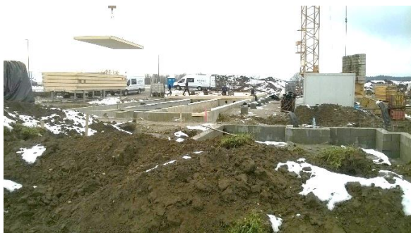
Abbildung 11: Montage Bodenplatte in Holz
