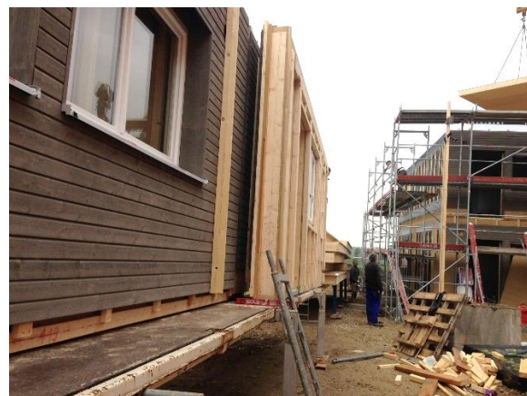
Abbildung 10: Transport der Elemente
