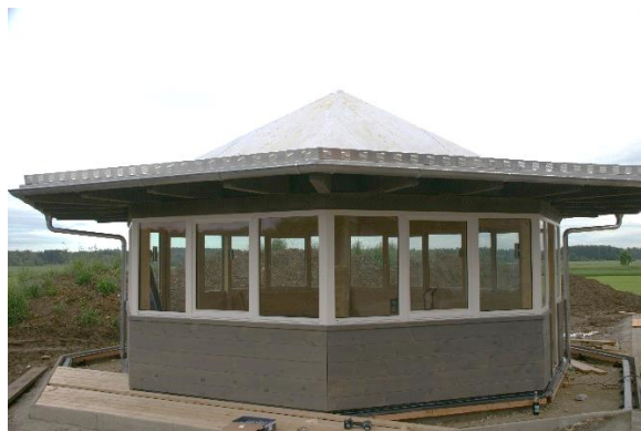
Abbildung 14: Außenansicht Oktagon Bauphase II
