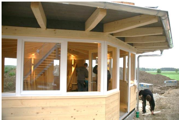
Abbildung 7: Oktagon während der Bauphase
