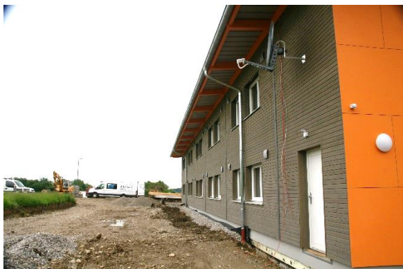
Abbildung 13: Fertige Fassade Südbau
