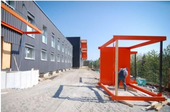
Abbildung 6: Foto, Fassade mit Balkonen
