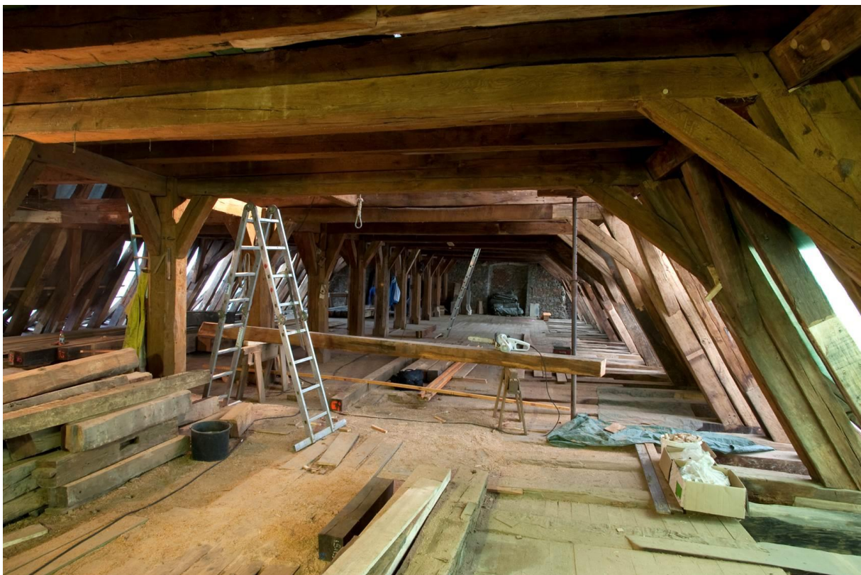
Abbildung 8: Dachgeschoß während der Sanierung
