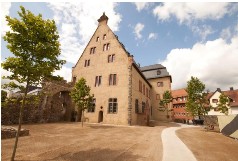
Abbildung 2: Solms – Hohensolmscher Schloss nach der Sanierung
