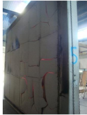
Abbildung 19: Unmittelbar nach Prüfe - große und viele Risse in Gipsfaserplatte - WA2
