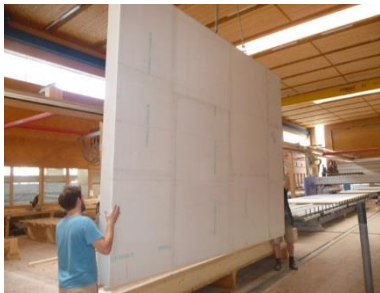
Abbildung 8: fertiges Element, 2. Lage Gipsfaserplatten
