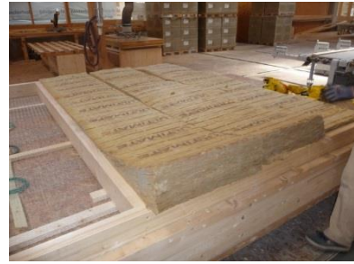
Abbildung 6: Gefachdämmung
