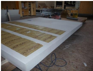
Abbildung 7: Anbringung 1. Lage Gipsfaserplatten
