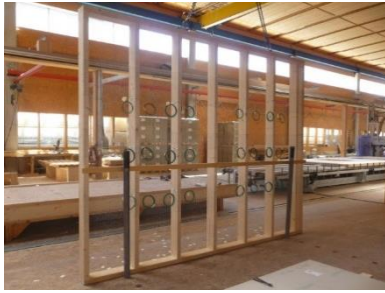
Abbildung 4: Vorfertigung der Holzrahmenkonstruktion mit Thermoelementen
