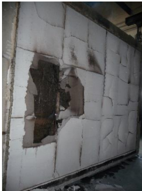
Abbildung 21: Öffnung der Beplankung - 6 Minuten nach Prüfe - WA1
