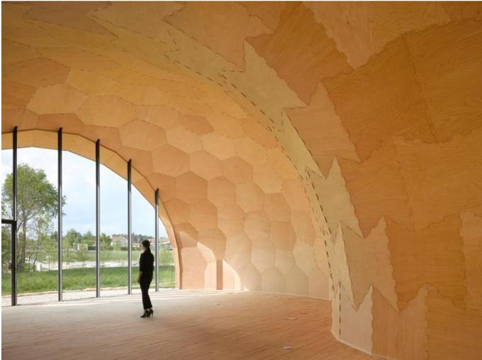
Abbildung 10: Robotisch gefertigter Pavillon LGS 2015, Schwäbisch Gmünd
