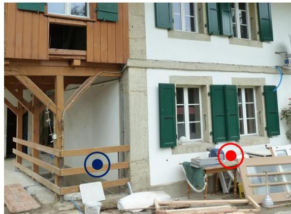
Abbildung 2: Einbauorte der Sensoren für Monitoring; Blaue Messstelle: Nordwestwand; Rote Messstelle: Südwestwand.
