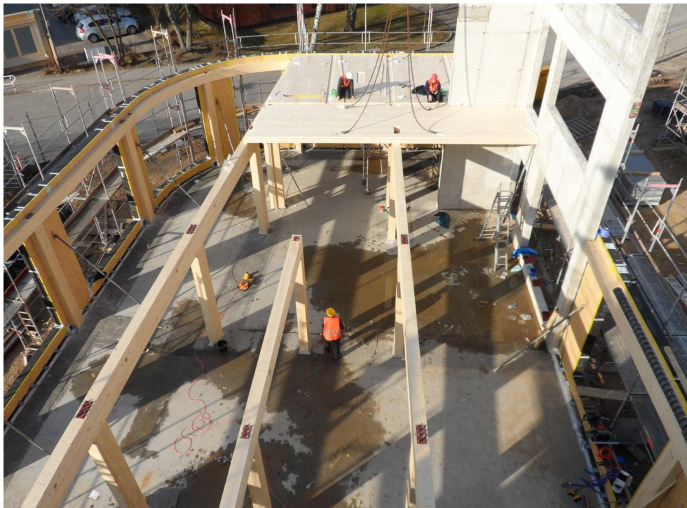
Abbildung 6: Montage Stützen/Unterzüge/Deckenelemente
