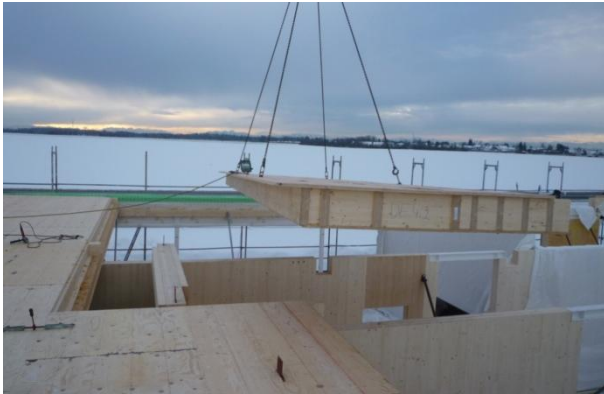
Abbildung 11: Einschwebendes Dachelement
