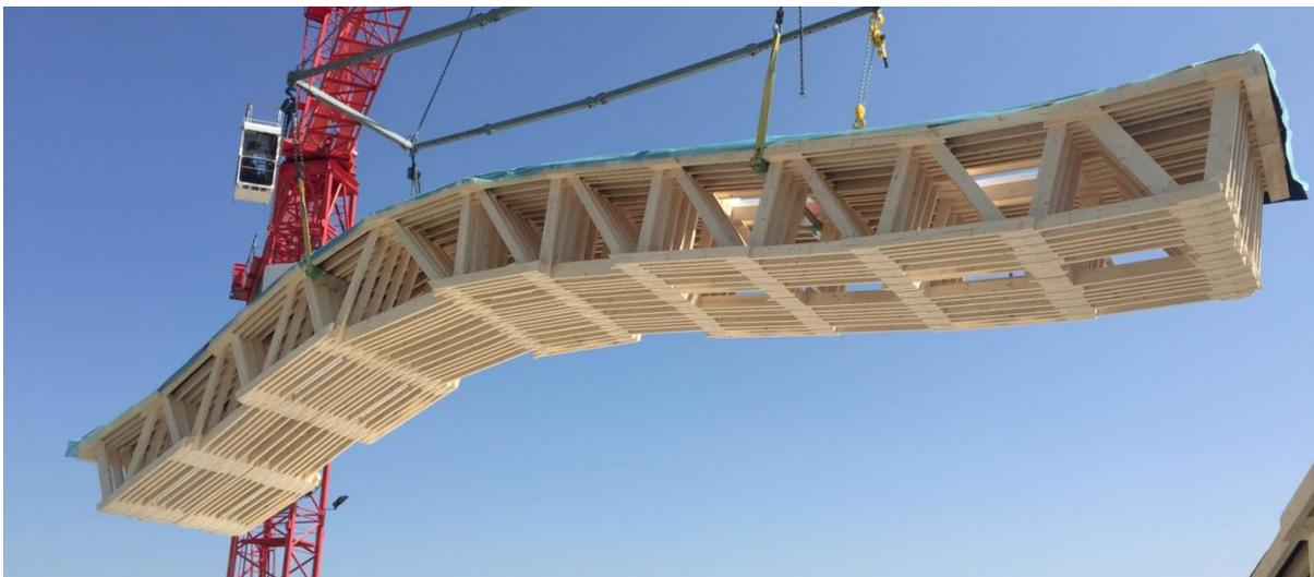
Abbildung 17: Montage der Träger
