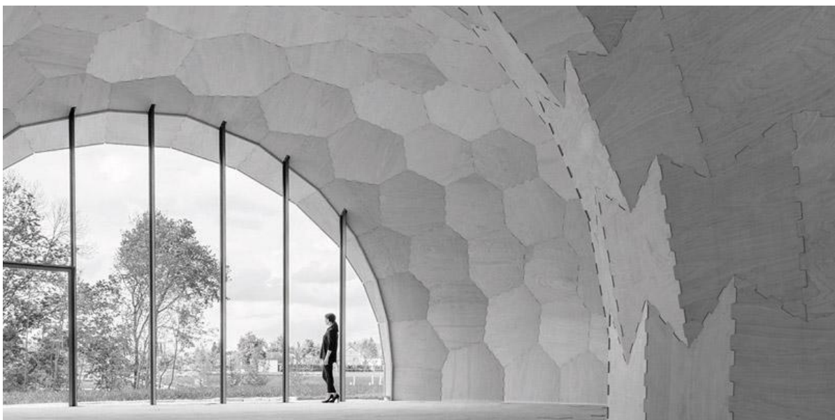
Abbildung 1: Computerbasierter Holzbau: Der Forstpavillon auf der Landesgartenschau.
