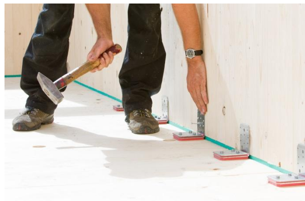
Abbildung 13: Vernageln des Winkels
