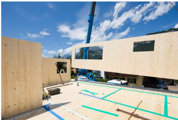
Abbildung 10: Verlegte Sylodyn® Lager
