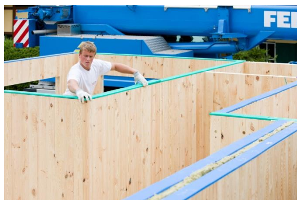
Abbildung 7: Verlegen der Sylodyn® Lager
