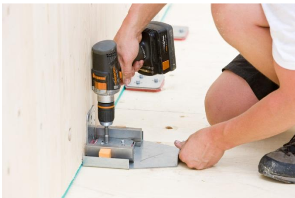
Abbildung 12: Verschrauben des Winkels
