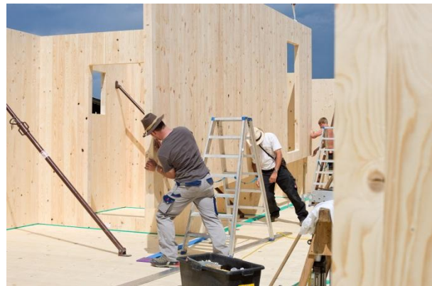
Abbildung 11: Aufstellen der OG Wandelemente
