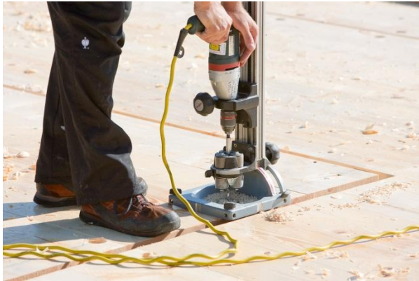
Abbildung 8: Vorbohren der Schraubenlöcher
