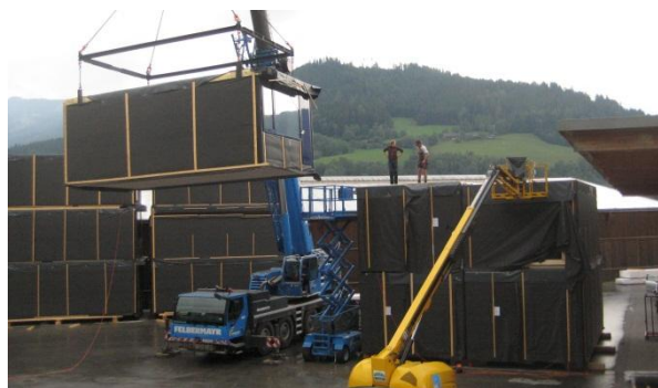
Abbildung 18: Stapeln der Module (Quelle: Künz)
