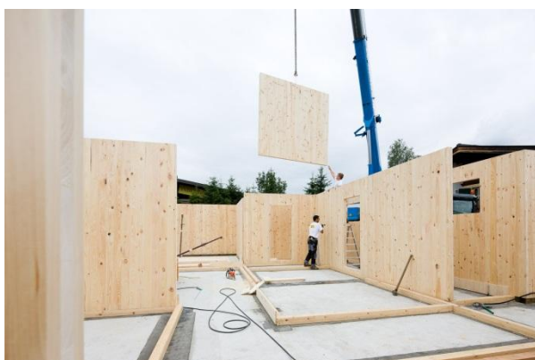
Abbildung 6: Aufstellen der Erdgeschosswände
