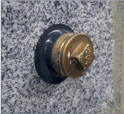
Rohrdurchführung mit Dichtmanschette
