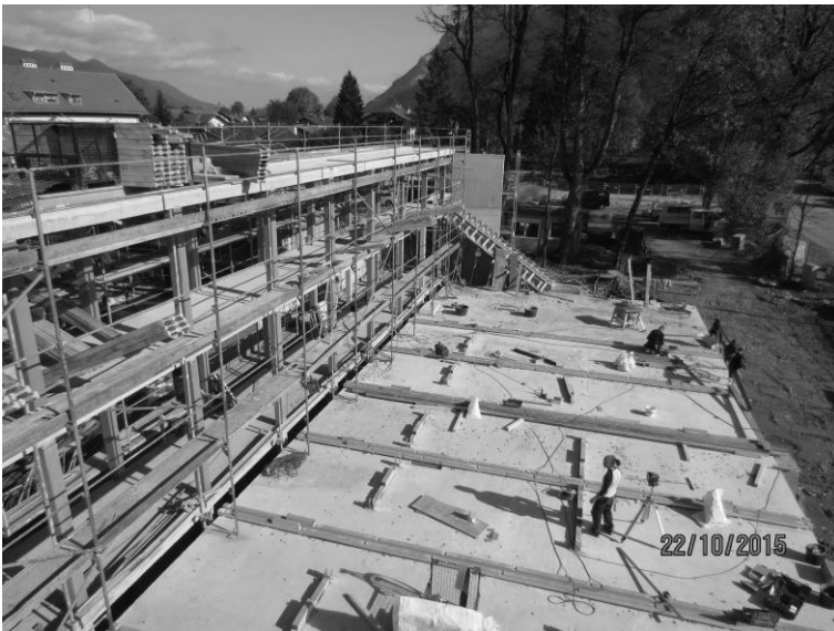
Abbildung 13: Baustelle der Regalstruktur aus Beton mit Aufstellung der vorgefertigten Holzelemente
