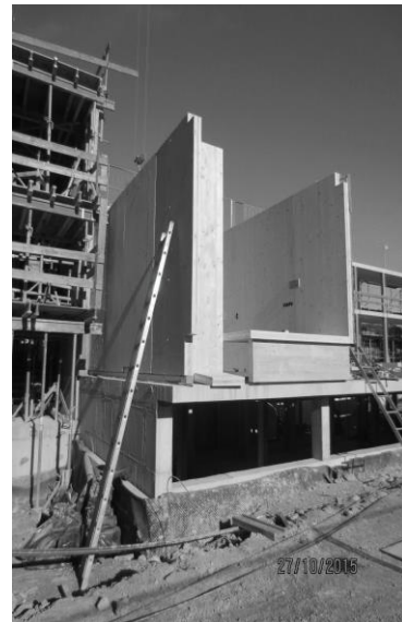
Abbildung 13: Baustelle der Regalstruktur aus Beton mit Aufstellung der vorgefertigten Holzelemente
