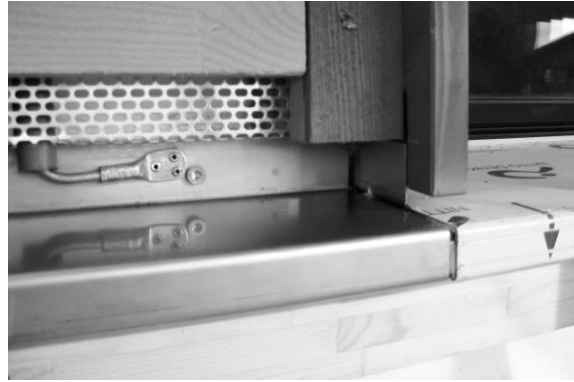
Abbildung 9: Fensteranschluss, Blitzschutz, Brandschutzschürze
