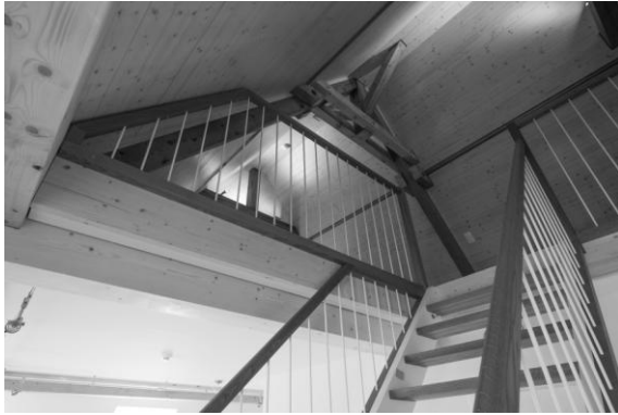
Abbildung 5: Dachstockausbau in Deisswil, 2015
