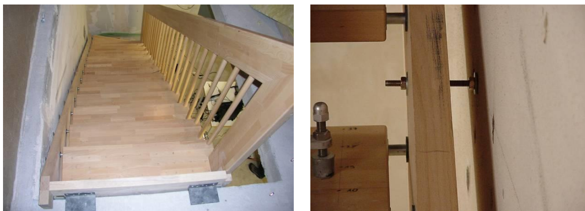
Abbildung 5: Handwerkliche Holztreppe mit Wandwange und punktförmigem Wandkontakt.
