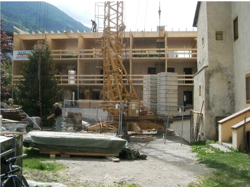
abbildung 4: hotel hinteregger bauphase
