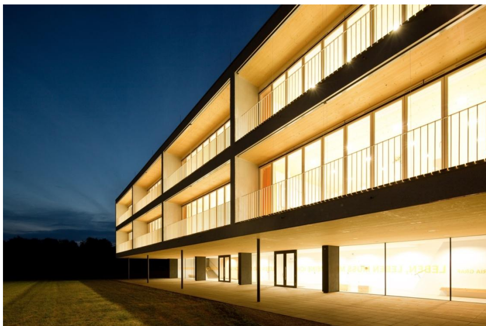
Abbildung 3: Ansicht Süd mit Eingangsbereich
