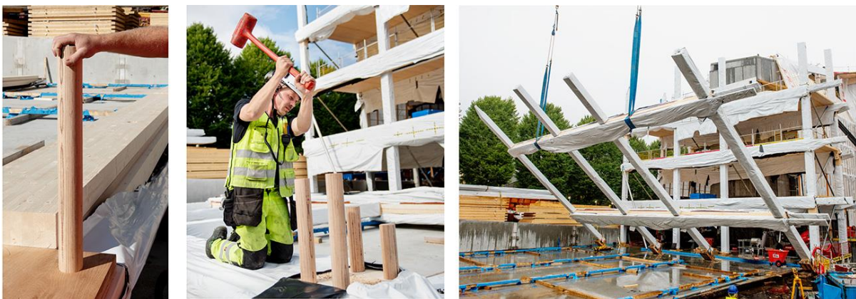
Abbildung 7: Montage der Rahmen
