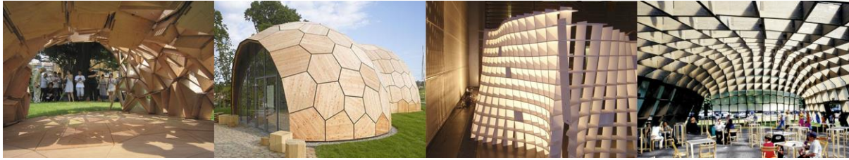
Figure 1 : Gauche à droite. 130008252010 pavilion, Liotta 2010. Landesgartenschau Exhibition Hall, A. Mengues 2014. Prototype experimental, les Grands Ateliers. Lyon-France 2012. Serpentine pavilion, Londres, A. Siza 2005.
