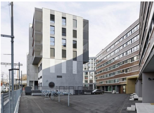
Abbildung 5: Blick von der Bahn zum Wolframplatz; links das «pile up», rechts der «Wohnmäander», zuhinterst das «Boarding House»
