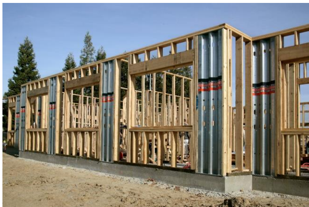
Exemple de construction ossature bois avec Steel StrongWall™
