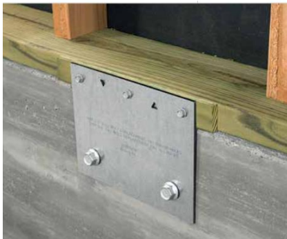
Renforcement de la liaison avec la fondation
