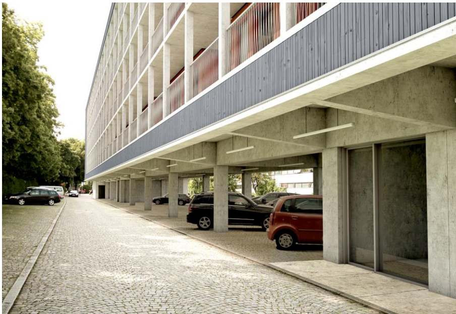
Abbildung 1: Blick auf Stellplätze und Laubengängerschließung
