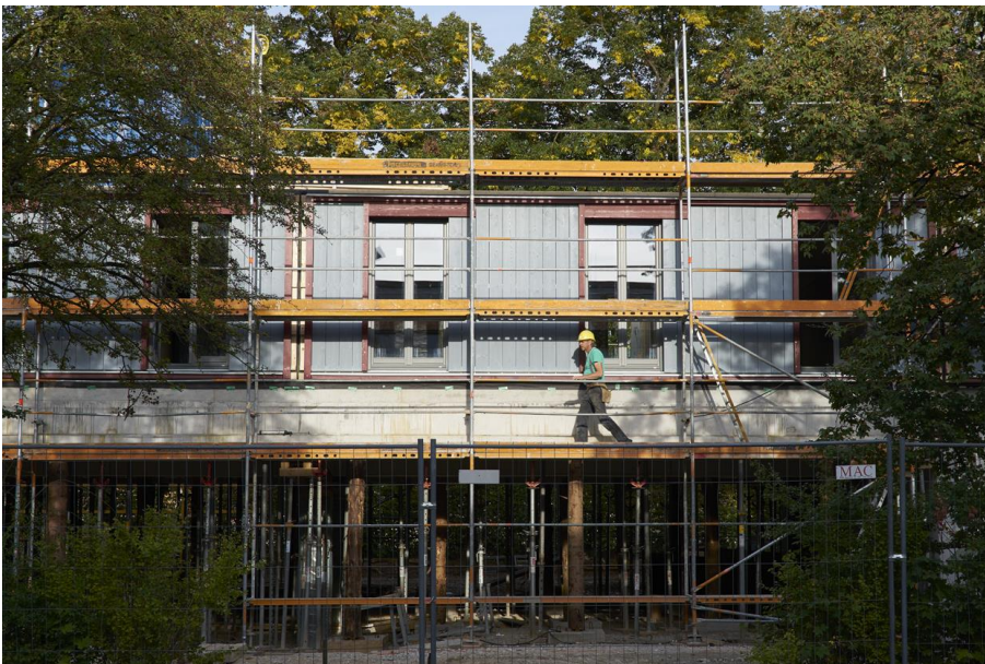
Abbildung 6: vorelementierte Fassade
