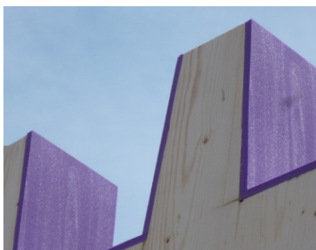
Entkopplung von Wand- und Bodenplatte
