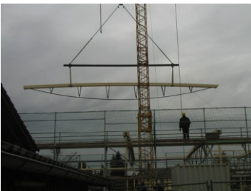
Brettstapelelemente mit eingebauten Ligno-Akustikelementen
