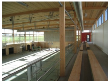
Brettstapelelemente mit eingebauten Ligno-Akustikelementen
