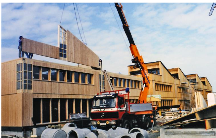
Abbildung 3: Baufoto «fliegendes Element», PROSA, Au SG/CH
