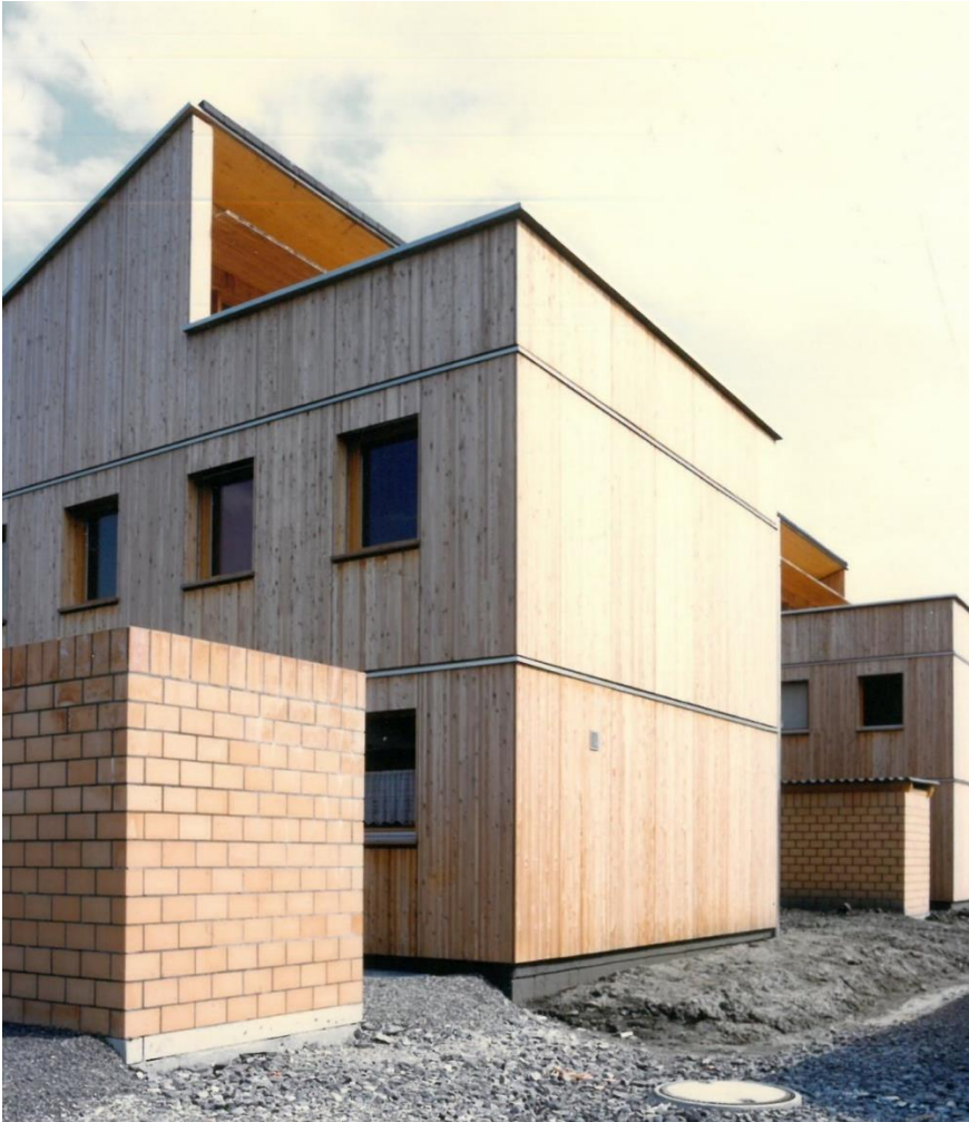
Abbildung 2: Baufoto, Aussen, PROSA, Au SG/CH
