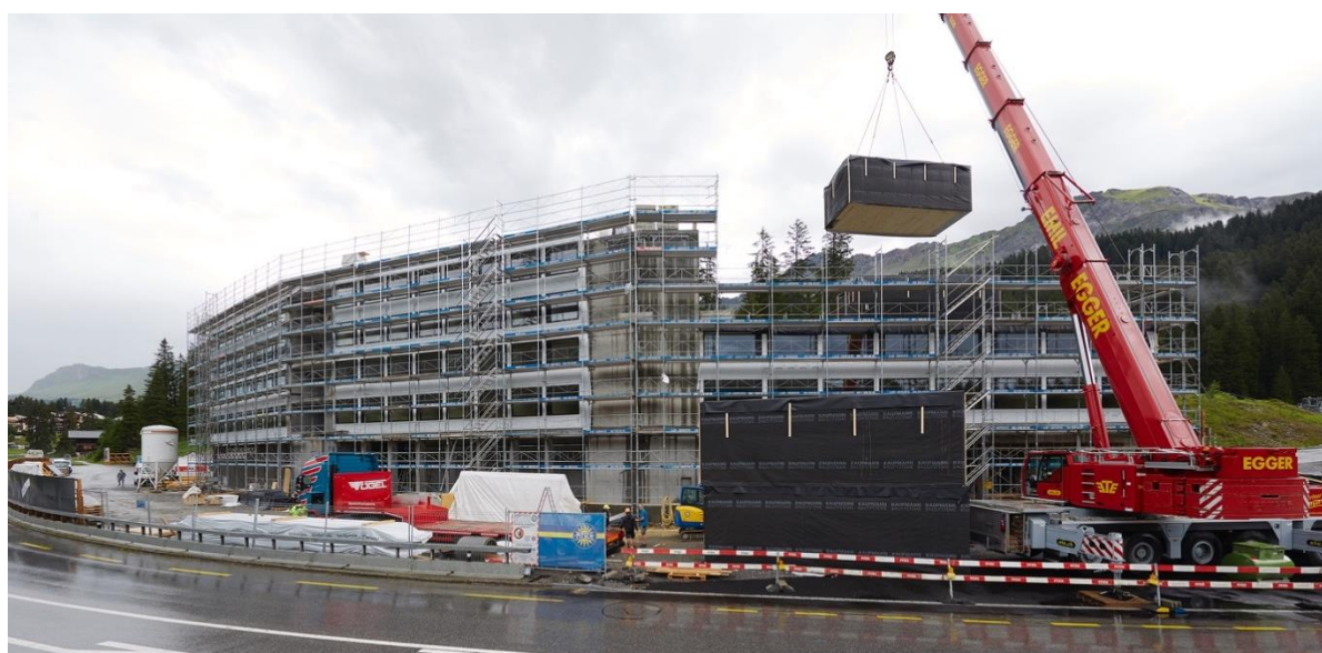
Abbildung 16: Baufoto, Hotel Revier, Lenzerheide/CH
