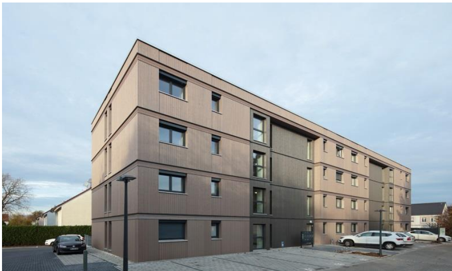
Abbildung 1: Systemhaus Hanau, Lenbachstraße
