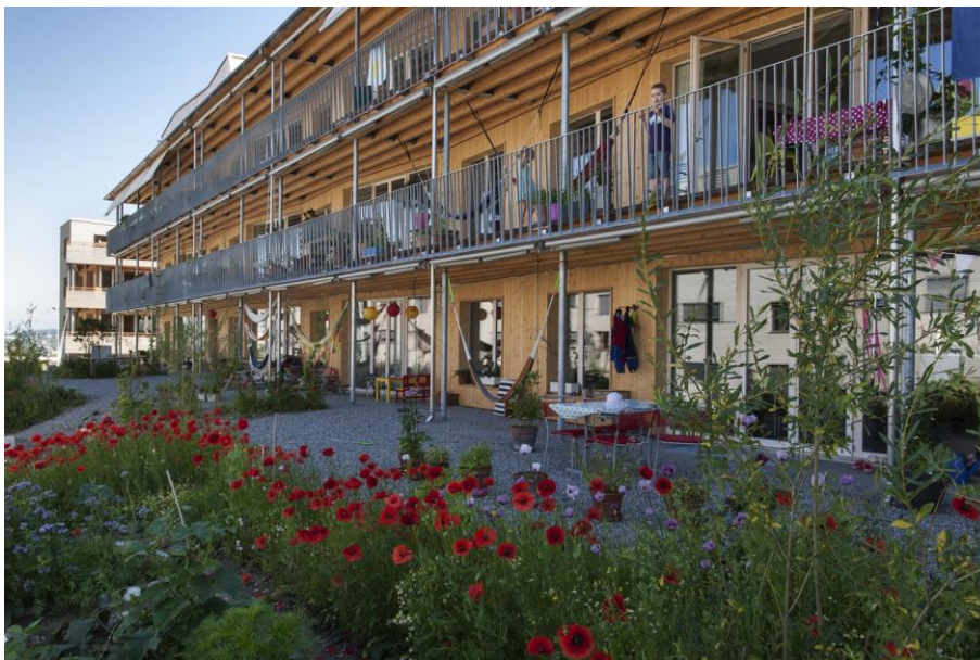
Westfassade des Gebäudes mit Laubengangtypologie. Baujahr 2012-2014. Die Siedlung umfasst 100 Wohnungen (50 Eigentums- und 50 Mietwohnungen), zwei Gemeinschaftsräume, zwei Kitas, naturnahe Aussenräume und 600 gedeckte Fahrradstellplätze.
