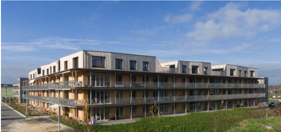
Die Süd- und Ostfassade des Gebäudes mit Laubengangtypologie
