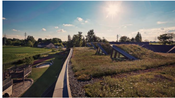
Abbildung 23: Dachlandschaft (Foto: Jakob Kanzleitner)
