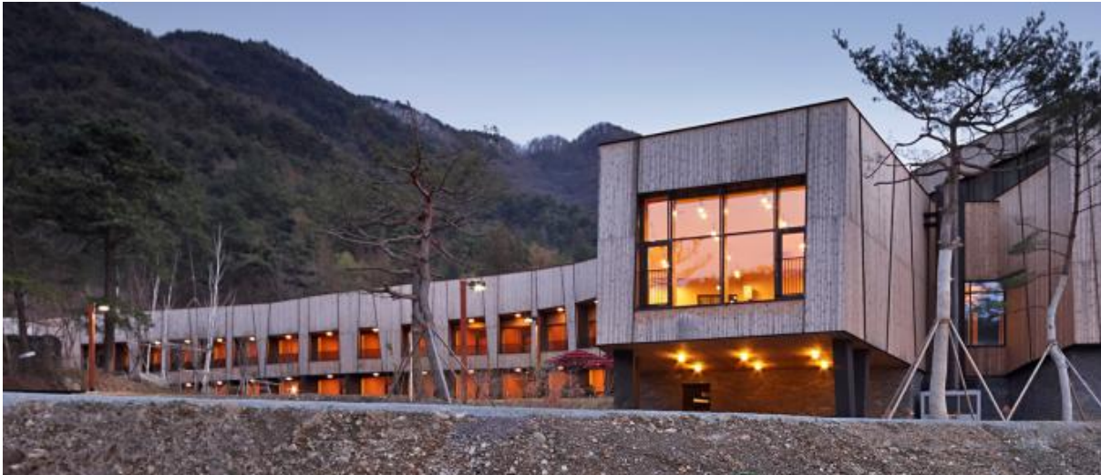
Abbildung 10: Nordseite mit den Apartments – Jugend- und Gästehaus Pulmuone (Foto: Woosang Yang)
