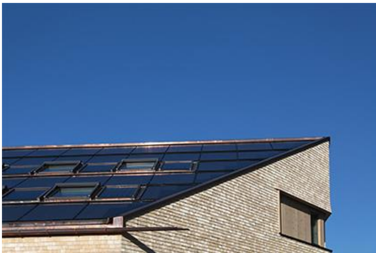
Abbildung 4: Haus am Berg, Sulzberg, Detail
