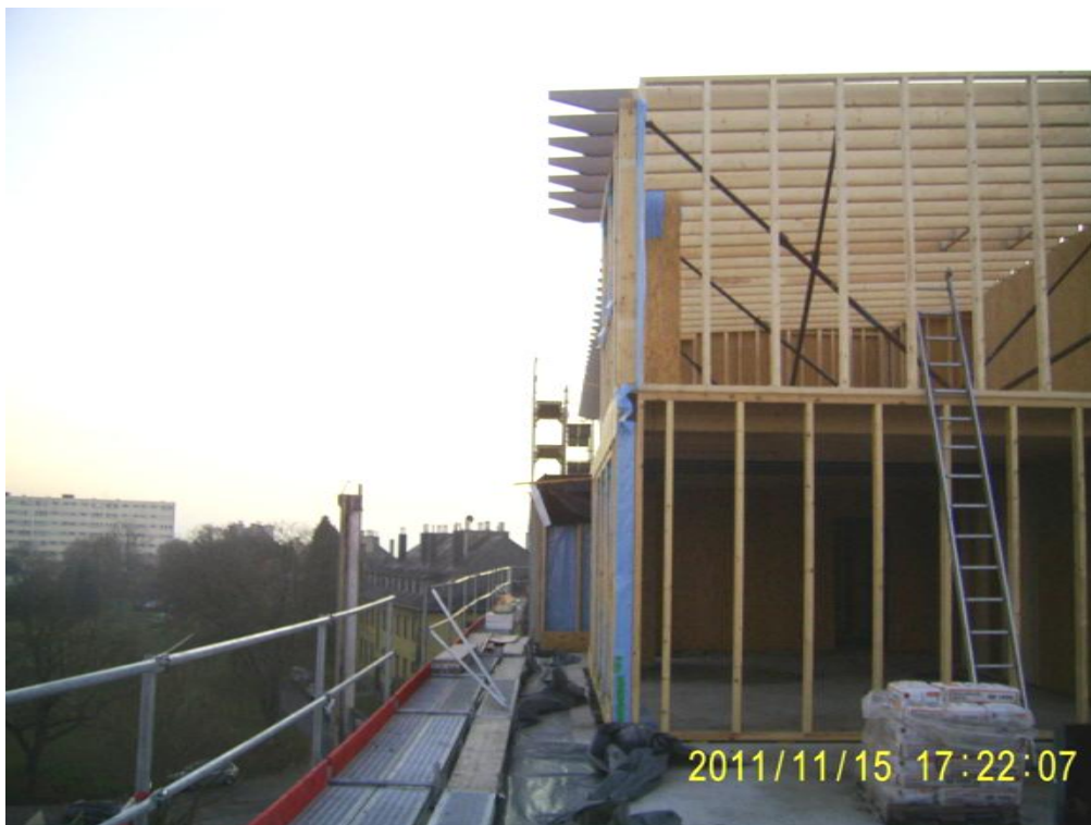
Abbildung 7: Gebäude Nr. 1 – Holzrahmenbauweise, Foto: Firma Ochs
