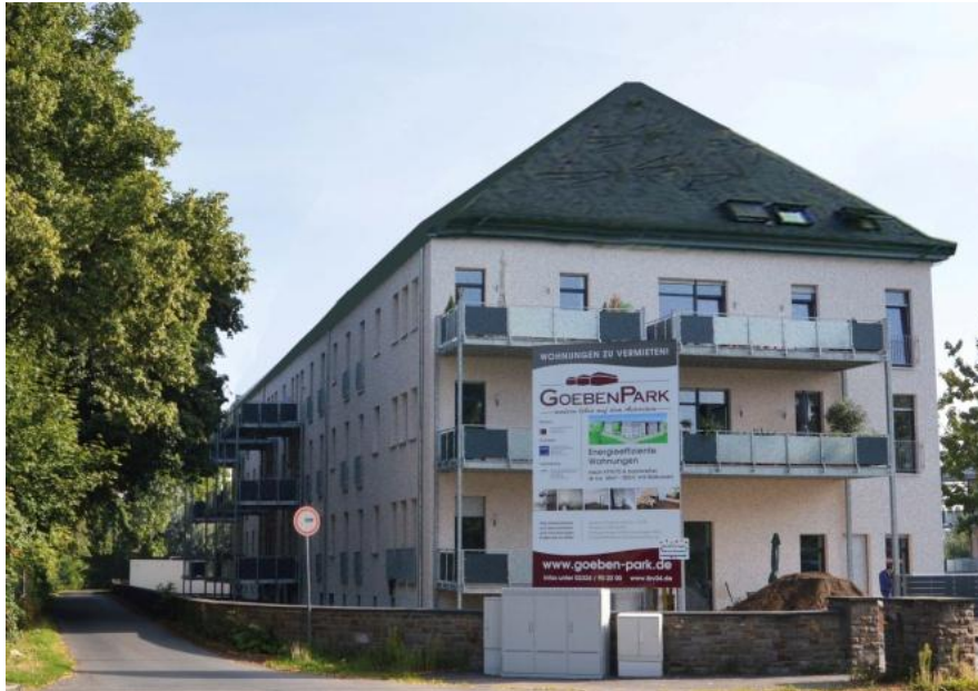
Abbildung 2: Gebäude Nr. 1 – vor Gebäudeaufstockung, Foto: Firma Ochs
