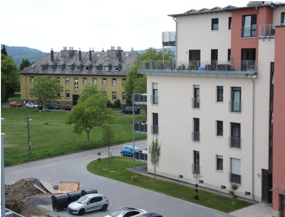
Abbildung 5: Gebäude Nr. 2 – im Hintergrund nicht saniertes Gebäude
