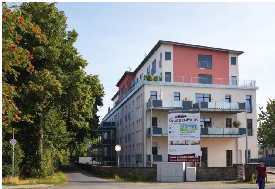
Abbildung 3: Gebäude Nr. 1 – nach Gebäudeaufstockung, Foto: Firma Ochs
