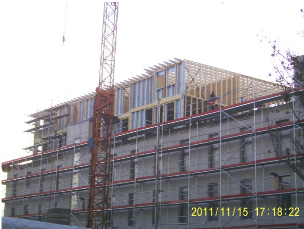
Abbildung 6: Gebäude Nr.1 – Holzrahmenbauweise, Foto: Firma Ochs
