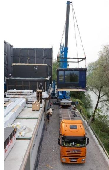
Abbildung 3: Versetzen der Module (© Andrew Phelps)
