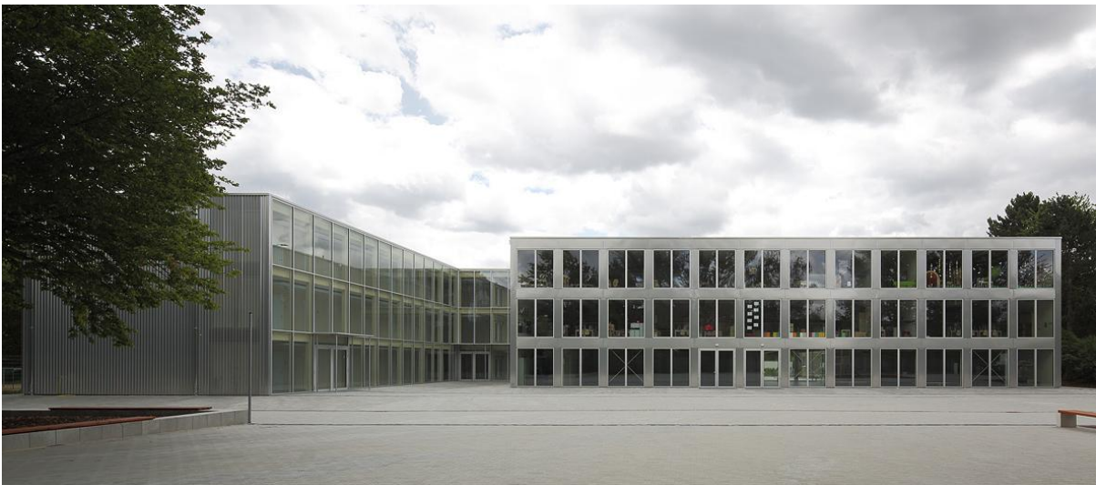
Abbildung 6: Gebäudeansicht | RADON photography / Norman Radon
