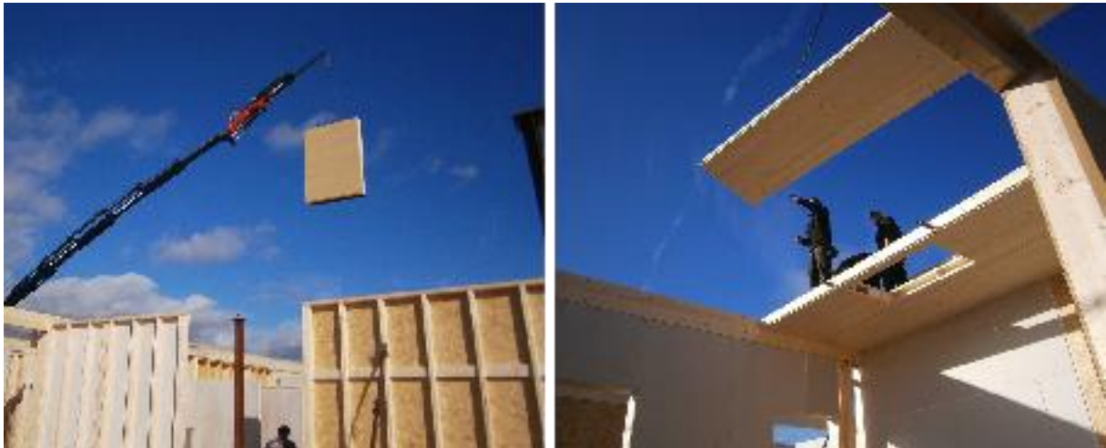
Abbildung 3 + 4: Impressionen vom Montieren der Holzmodulbauwände und Lignatur 3 -Deckenelemente
