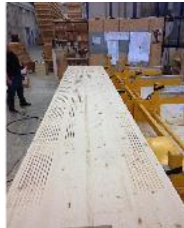
Abbildung 22: Abbund Lignatur 3 Deckenelement
