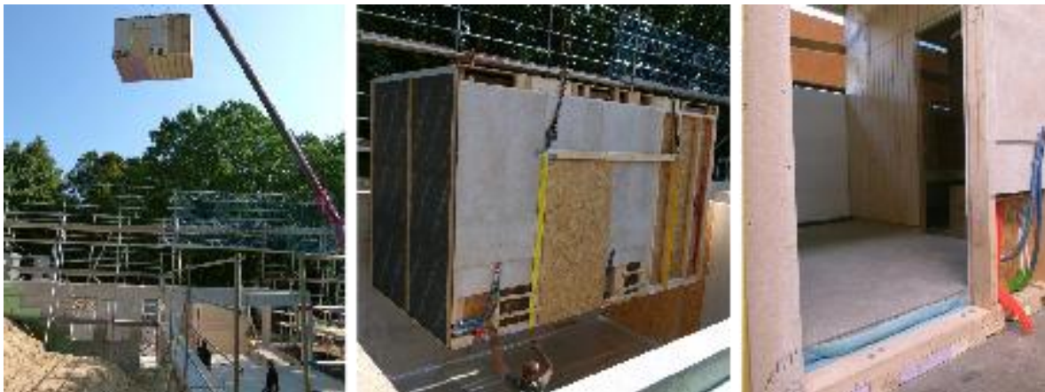
Abbildung 26 - 28: Vorgefertigte Sanitärboxen werden auf der Baustelle montiert
