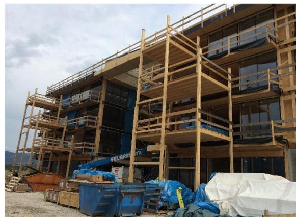
Abbildung 14: Hilfskonstruktion zur Materialeinbringung
