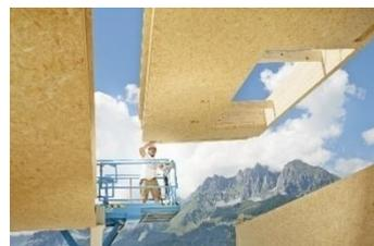
Abbildung 20: Deckenelement bei Montage (Bild: EGGGER, Fotograf Christian Vorhofer)
