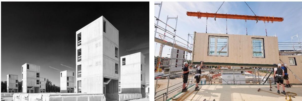
Abbildung 6/7: Treppenhäuser (links), BSP-Elemente Montage (Brüggemann), Fotos: O. Mahlstedt, Hannover
