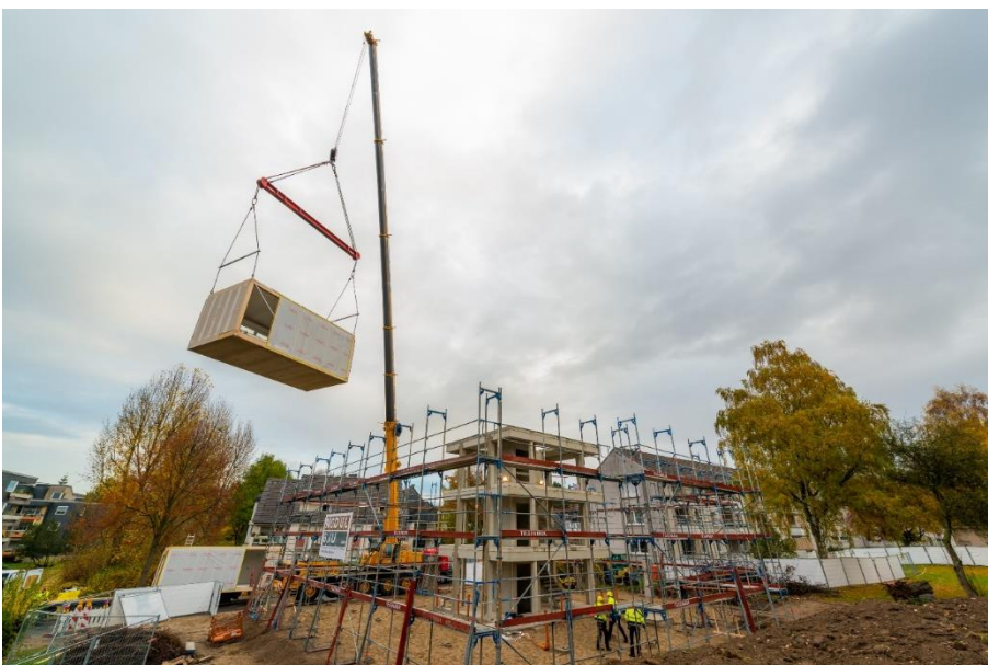
Abbildung 5: Baustelle in Bochum-Hofstede © Simon Bierwald/Vonovia
