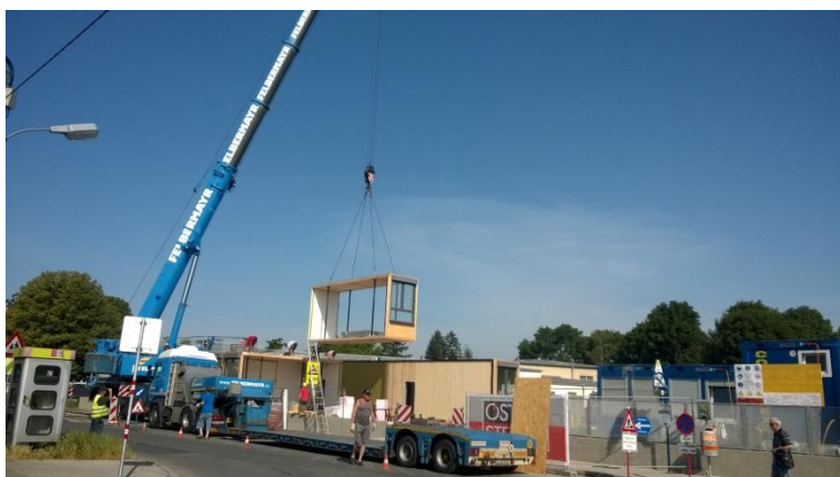
Abbildung 7: Verhub der Raumzellen, WIP GmbH, Juli 2014.
