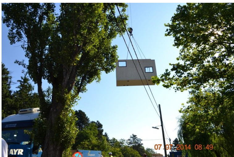
Abbildung 8: Verhub der Raumzellen 2, WIP GmbH, Juli 2014.
