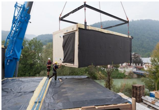
Abbildung 1: Modulmontage
