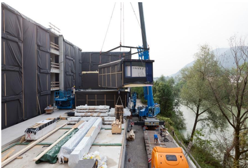
Abbildung 18: Montage der Module
