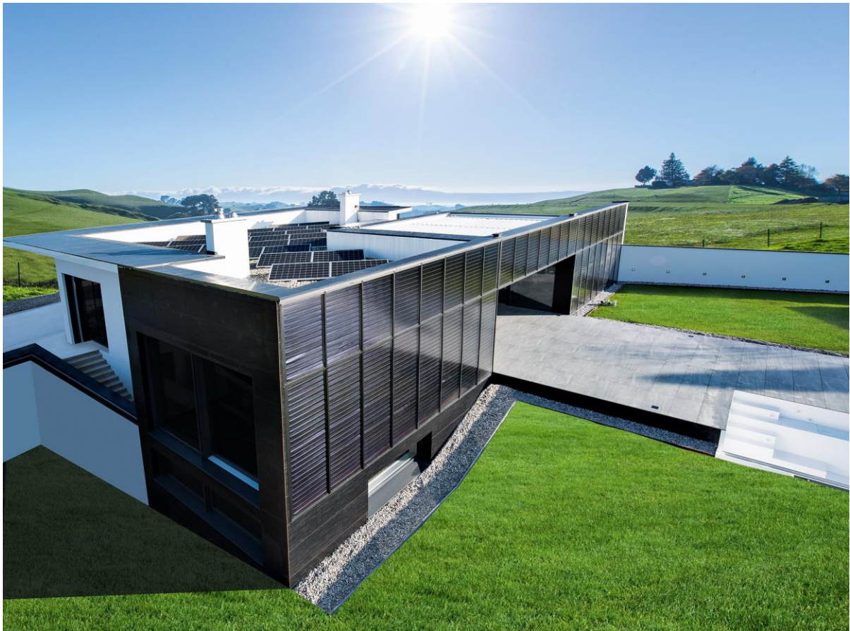
Abbildung 5: VitalSonnenhausPro der Firma Bauhütte Leitl-Werke GmbH: Entwurf des ersten energieautarken Gebäudes Österreichs, derzeit in Schwertberg/Österreich im Bau, Fertigstellung Oktober 2016. Es ist barrierefrei. Wärme, Strom und Mobilität kommen von der Sonne. Zum Einsatz kommen Solarthermie mit Langzeitwärmespeicher, Photovoltaik und Akku sowie Pelletkessel mit Sterlingmotor. Quelle: Bauhütte Leitl-Werke
