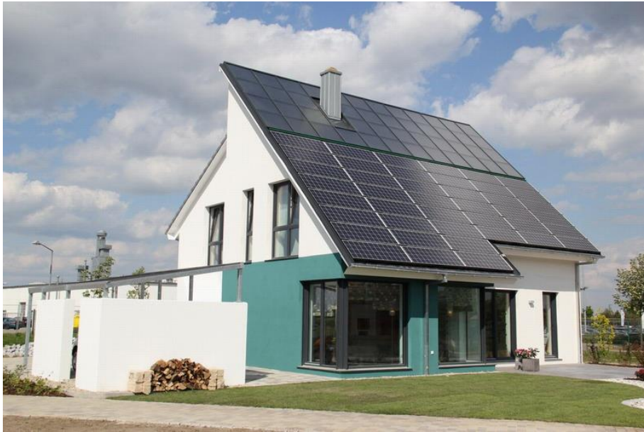
Abbildung 3: Erstes bezahlbares energieautarkes Eigenheim Europas als unbewohntes Musterhaus in Lehrte/Hannover von der HELMA Eigenheimbau AG Baujahr 2011. Es versorgt sich selbst durch Solarthermie + Langzeitwärmespeicher und Photovoltaik + Akku sowie etwas Biomasse mit Wärme, Strom und E-Mobilität. Primärenergiebedarf: 7 kWh/m 2 a.
