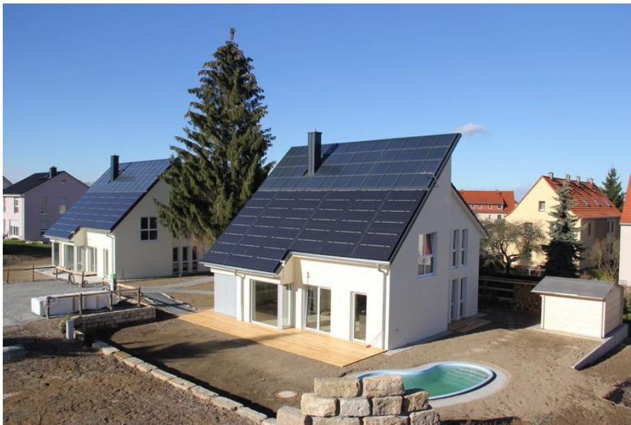
Abbildung 4: Intelligente Eigenversorgung mit Wärme, Strom und Mobilität aus der Sonne. Das Haus wird zur Tankstelle. Es hat eine Wohnfläche von 161 m 2 , Solarthermie 46 m 2 mit 9 m 3 Langzeitwärmespeicher, 8,4 KWP Photovoltaik mit 58 kWh Akku. Die ersten beiden bewohnten energieautarken Einfamilienhäuser Europas in Freiberg/Sachsen, errichtet von der HELMA Eigenheimbau AG Baujahr 2013. Drei Jahre lang werden diese beiden Häuser durch die TU Bergakademie Freiberg messtechnisch untersucht. Primärenergiebedarf: 7 kWh/m 2 a, Stromverbrauch 2.100 kWh/a, Holzbedarf 2-3 rm/a.
