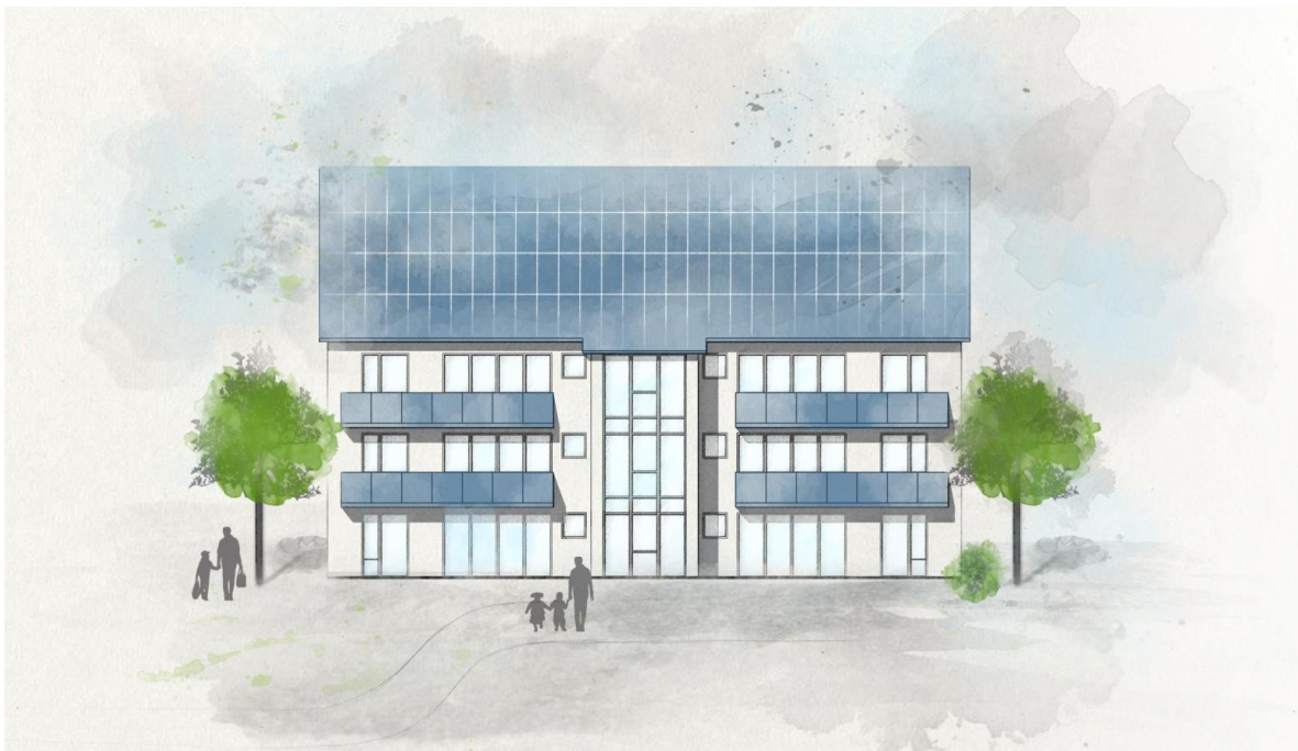
Abbildung 10: Miete mit Energieflat: Energieautarkes Mehrfamilienhaus mit 6 Wohneinheiten in Norddeutschland. 88 m 2 Solarthermie mit 18 m 3 Langzeitwärmespeicher sowie 22 KWP Photovoltaik auf dem Dach und an den Balkonen mit 96 kWh Akku erreichen rund 70 % solare Deckung bei Strom und Wärme. Der Vermieter kann dem Mieter für mehrere Jahre eine Pauschalmiete anbieten, in der Wohnen, Wärme, Strom und E Mobilität als Flatrate bereits enthalten ist.
