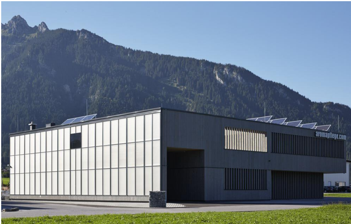
Abbildung 9: Gewerbeobjekt in Österreich. Aromacampus Baujahr 2016. In Lechaschau Österreich Bj. 2016 mit 770 m 2 Nutzfläche, Niedrigstenergiestandard Hz rund 28.000 kWh/a, rund 30 kWh/m 2 a, Solarthermiefassade 140 m 2 mit 25 m 3 Langzeitwärmespeicher, Photovoltaik 24 Kwp mit 40 kWh Akku LiIo, Restenergiebedarf wird gedeckt mit Rapsöl BHKW, Solare Deckung Wärme ca. 76 %, Solare Deckung Strom ca. 80 %, Bildquelle: Holzbau Saurer Fotograf Müller
