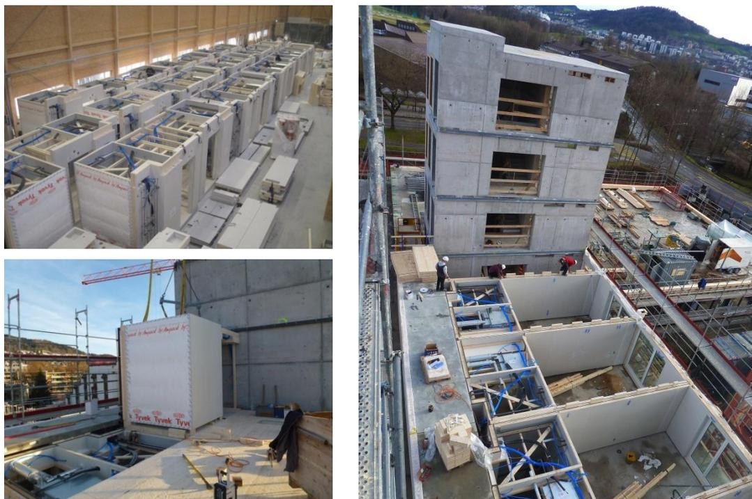
Abbildung 8: Kombination von Raumzellen mit flächigen Elementen [3]
