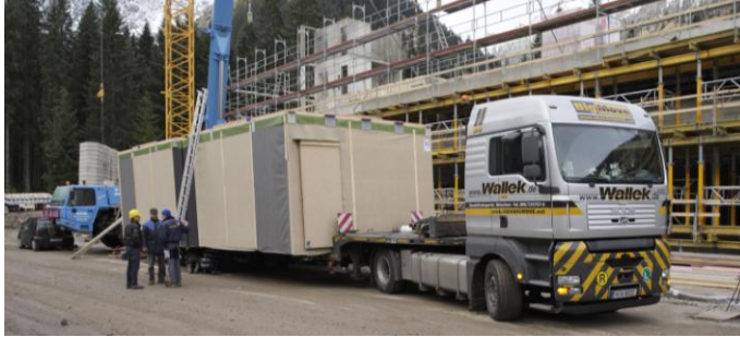
Abbildung 4: Transport von vorgefertigten Raumzellen
